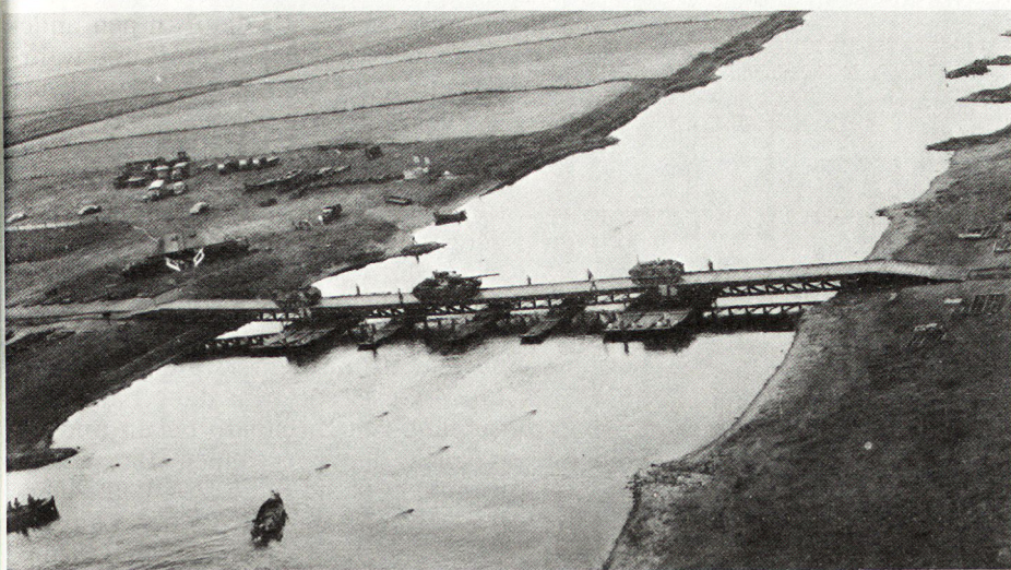
Bild 3. Eine 95 m lange zweistöckige MGB-Schwimmbrücke.
