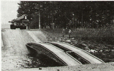
Bild 5. Brücke verlegt, Panzer marschbereit
