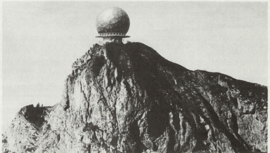
Bild 1. Radaranlagen für die Grossraumüberwachung gehören zu den primären Zielen eines Angreifers.
