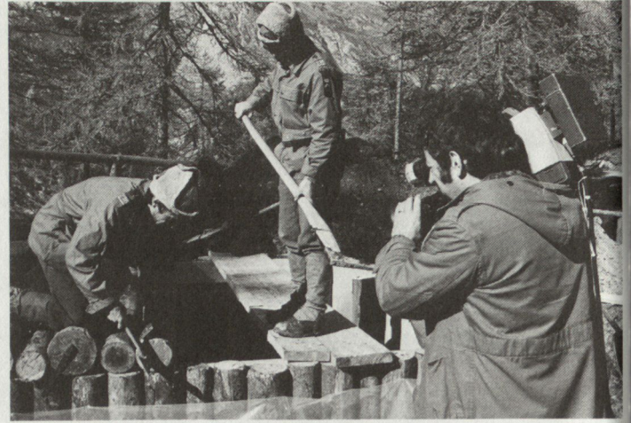
Bild 2. TV-Equipe beim Bau eines Unterstandes.
