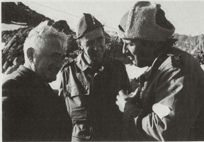
Bild 3. Der Chef EMD informiert sich über den Seilbahnbau am Scalettapass.
