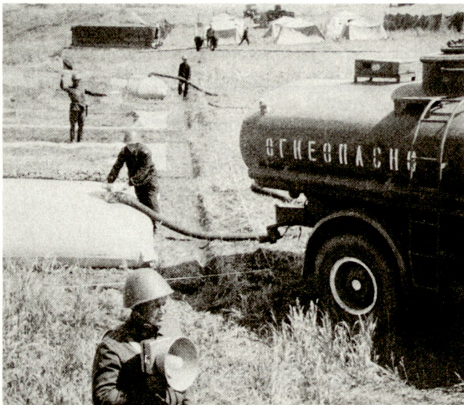
Abb.7. Anlegen von Betrst Lagern in stationären Gummibehältern
