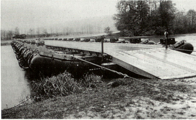
Abb. 2: Von der Schlauchbootbrücke 61...
