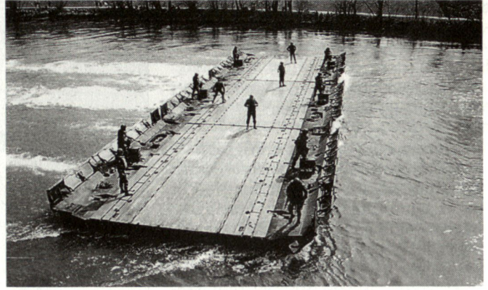
Abb. 3: ... zur Schwimmbrücke 95 (Versuchsstab Genie)
