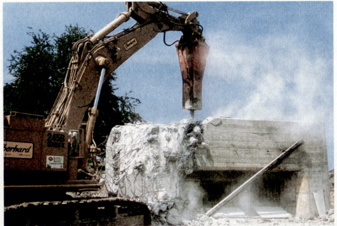
Rückbau eines Bunkers – eine aufwendige Sache.
