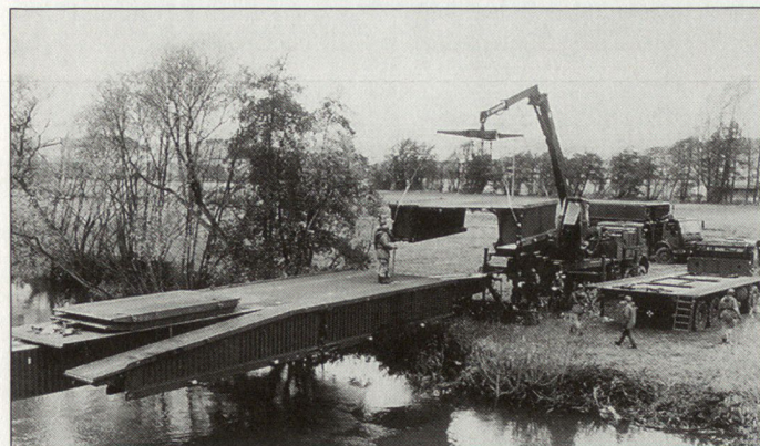
Faltfestbrücken für Österreich.
