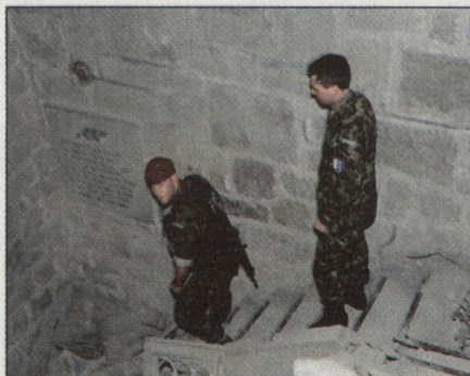
Der zerstörte Aufgang im Turm.
