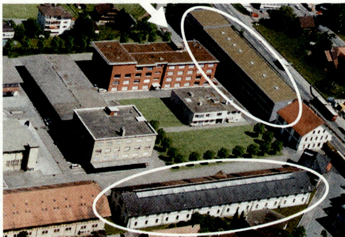
Fotomontage der Bauetappe 2: Neubau Fhr Sim II entlang der Autobahn (oben rechts), Unterkunft (unten), neue Zufahrt (oben). Bild: TTZ
