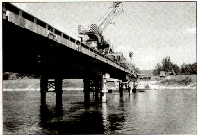
Stahlträgerbrücke des G Bat.
