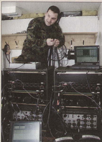
Installationsarbeiten. Foto: FU Basis
