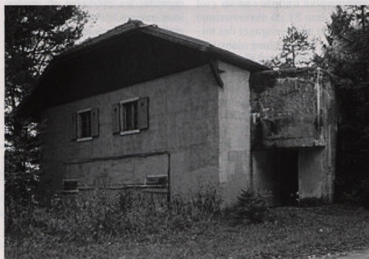
Pour la position de barrage de Lignerolle dans le Jura vaudois, le fortin «Les Rogets» fut camouflé en bâtisse civile. Bei der Sperrstelle Lignerolle, im Waadtländer Jura, wurde das Werk: «Les Rogets» als sozusagen ziviles Gebäude getarnt.
