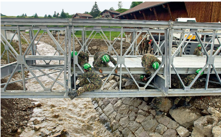
Genietruppen beim Brückenbau.
