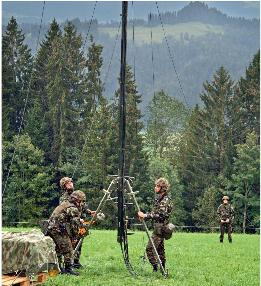
Kader beim Antennenbau.
