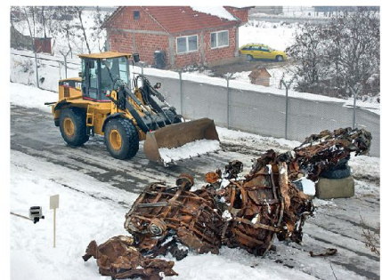
Räumung eines Roadblocks mit schwerem Gerät.
