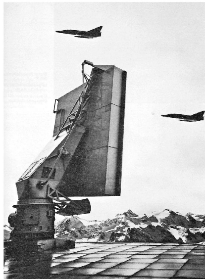
FLORIDA-Radarantenne auf einem Höhenstandort.
