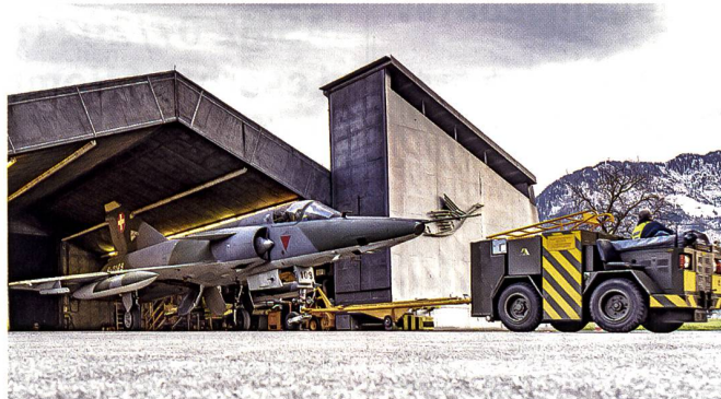
Das 1967 auf dem Flugplatz Buochs erstmals in Betrieb genommene «Bremshaus» ermöglicht Tag und Nacht Testläufe ohne Lärmbelastung der Bevölkerung sowie gute Arbeitsbedingungen für das Personal.
