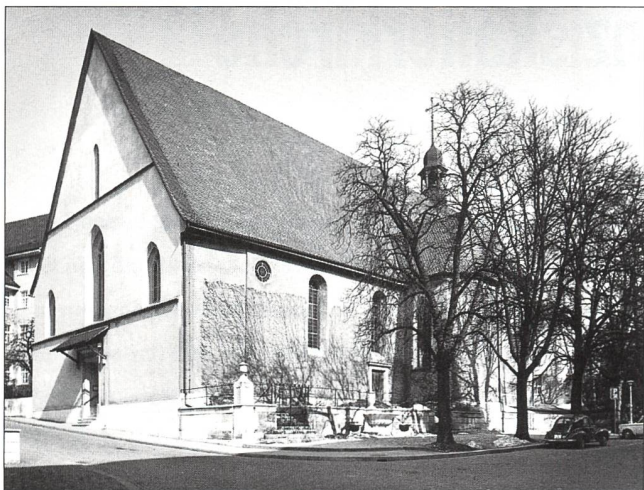
Abb. 2 Ehemalige Franziskanerkirche, Südseite, Zustand 1982.
