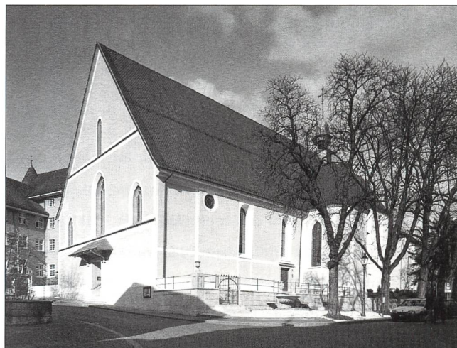
Abb. 3 Südseite, Zustand nach der Restaurierung 1994–1996.
