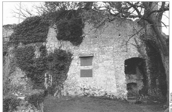
Abb. 16 Dornach, Ruine Dorneck. Innenseite (M1) des Grossen Bollwerks, Ausschnitt wie auf Abb. 15. Zustand 1998. Wenig links der stichbogig überwölbt Öffnung des Pulverturms (T5) ist die südöstliche Ecke des kleinstenigen Mauerwerks (M1b) zu erkennen.
