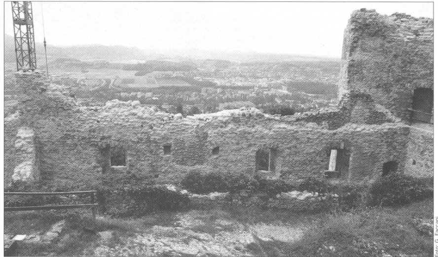
Abb. 27 Dornach, Ruine Dorneck. Innenseite des zweiten und des dritten Geschosses des Nordwestbaus, von Osten. Zustand nach der Restaurierung 1999.
