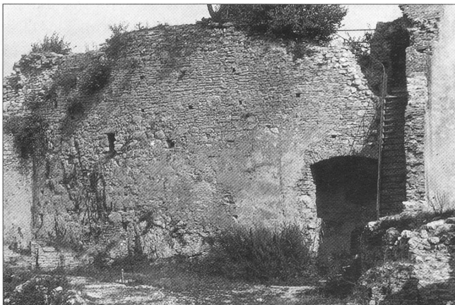
Abb. 15 Dornach, Ruine Dorneck. Innenseite (M1) des Grossen Bollwerks (B1). Zustand nach der Restaurierung von E. Probst (nach 1907/08). Im linken Bild Drittel ist das grossblockige Mauerwerk (M1a) mit der Öffnung zu erkennen, daneben in der Bildmitte der kleinstenige Abschnitt (M1b), der damals noch zu grossen Teilen flächig von Verputz verdeckt war. Im rechten Bild Drittel sichtbar der Pulverturm (T5) und die heute noch bestehende Eisentreppe zum Grossen Bollwerk.
