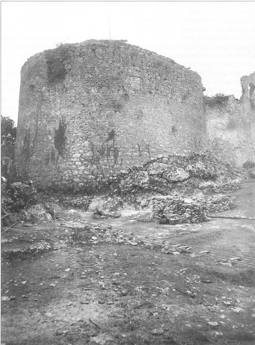
Abb. 43 Dornach, Ruine Dorneck. Grosses Bollwerk (B1), von Nordwesten. Zustand während der Restaurierung (1904–1907/08) von E. Probst.
