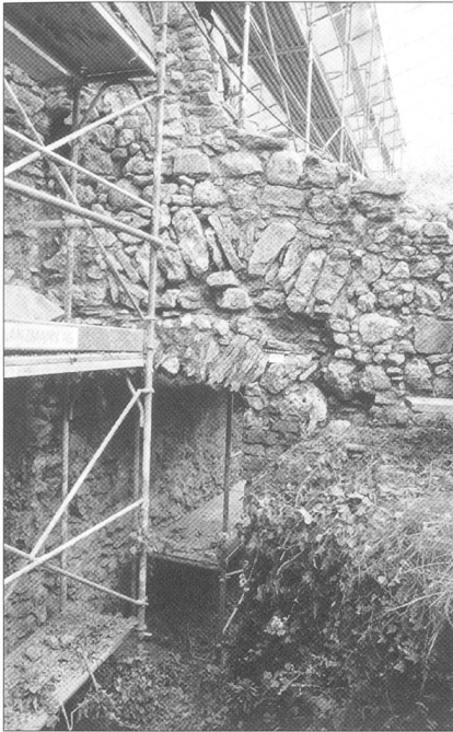
Abb. 25 Dornach, Ruine Dorneck. Südseite der Südmauer (M18) des Nordwestbaus. Zustand während der Restaurierung 1999. Über dem aktuellen Türsturz ist der ältere zu erkennen.
