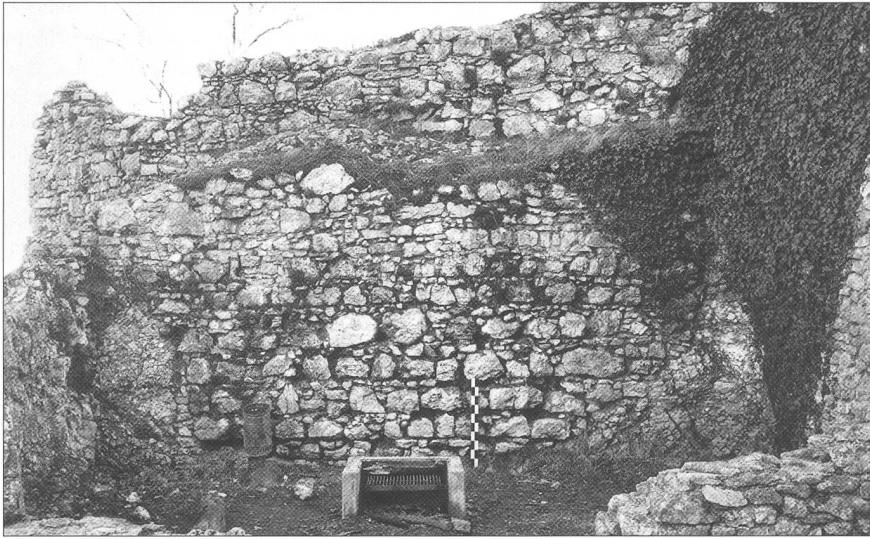
Abb. 28 Dornach, Ruine Dorneck. Vorhof, Nordmauer (M44) in den sogenannten «Stallungen». Zustand 1989.
