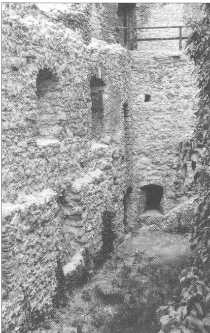
Abb. 26 Dornach, Ruine Dorneck. Nordwestbau, Blick gegen den nordwestlichen Innenwinkel, von Süden. Zustand nach der Restaurierung 1999. Zu beachten ist im Bereich unter dem nördlichsten Fenster, wie der horizontale Rücksprung endet.
