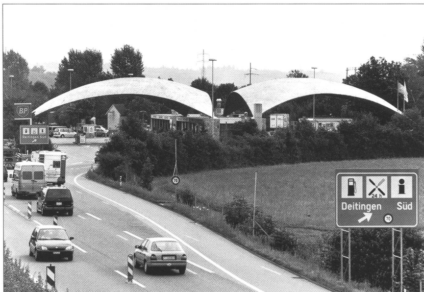
Deitingen, Autobahnraststätte Deitingen Süd, Ansicht von Westen.
