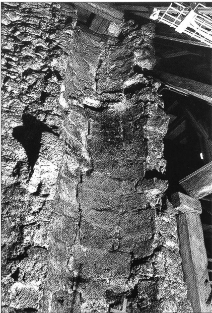
Abb. 34 Überreste der Wendeltreppe, die einst vom Lettner in den Estrich hinaufführte. Partie in der nördlichen Chormauer, im Estrichbereich des ehemaligen Refektoriums.
