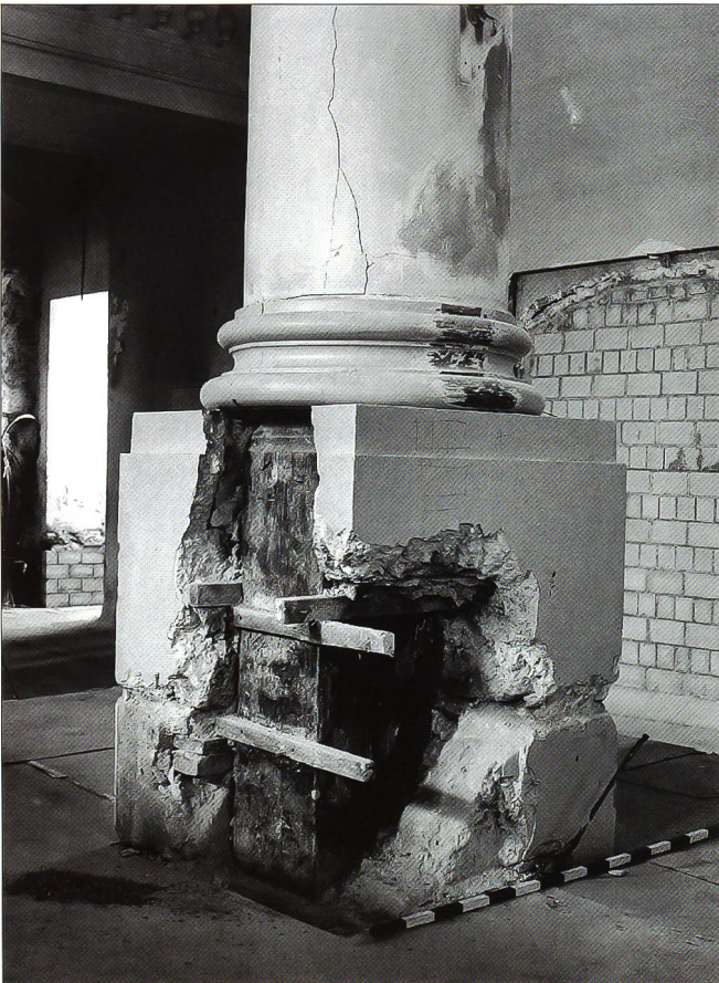
Abb. 17 Stütze im Schiff, anlässlich der Sondierungen zur Überprüfung der Statik, 1994.
