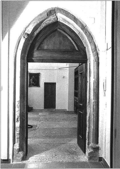
Abb. 33 Türöffnung vom ehemaligen Kreuzgang in den Chor, 1481 erneuert. Ansicht von der heutigen Sakristei aus.
