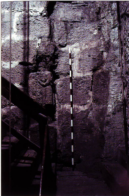
Abb. 2 Cheminéeanlage im ursprünglichen 2. Obergeschoss des Turms. Die mit einem Würfelkapitell abgeschlossene Viertelrundsäule stützte einst einen haubenförmigen Rauchfang. Stilistisch ist eine Datierung ins frühe 13. Jahrhundert möglich.
