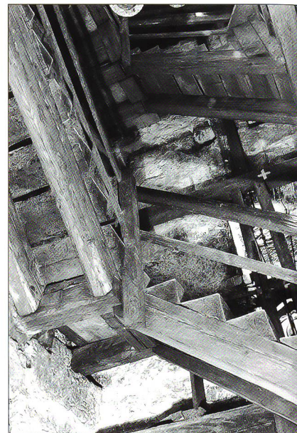
Abb. 16 Die Treppenanlage im Turminnern konnte dendrochronologisch ins Jahr 1541 datiert werden. Es handelt sich um eine Blockstufentreppe auf Holmen, die die alte Geschosseinteilung nicht mehr berücksichtigt.
