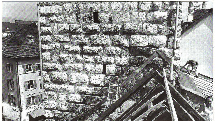
Abb. 6 3. Obergeschoss Westseite. Die grob zurechtgehauenen Quader besitzen bossierte Sichtflächen, die von einem schmalen Randschlag begleitet sind. Die Bossen zeigen zum Teil natürliche Oberflächen, zum Teil sind sie mit schlichten Methoden künstlich geformt. Quader ohne Bossen, hier in den beiden obersten Steinlagen des Bildausschnitts, entstanden durch nachträgliche Abarbeitungen im Zusammenhang mit der Errichtung von Zifferblättern.
