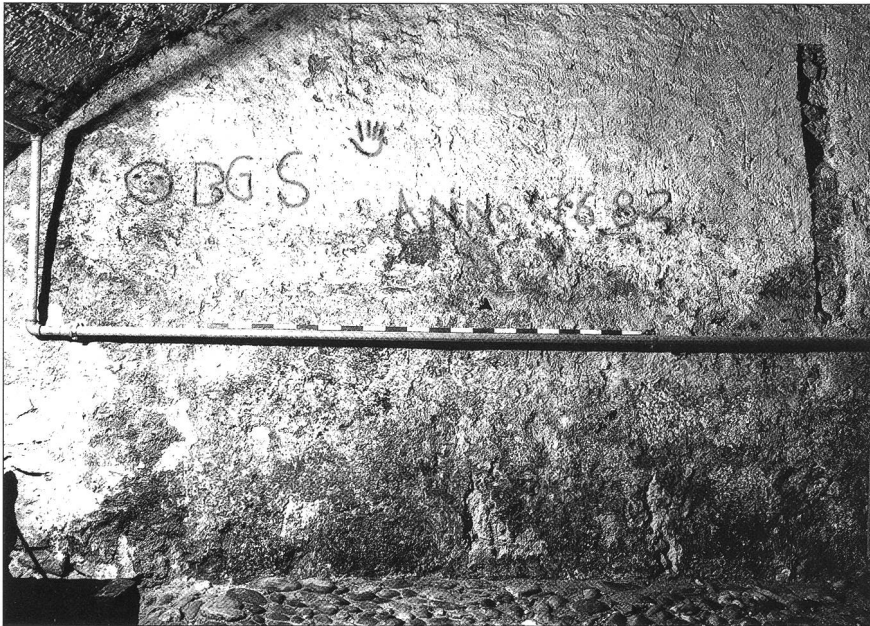
Abb. 2 Signatur BGS und Baujahr 1682, im Verputz der Nordwand, Fundzustand.
