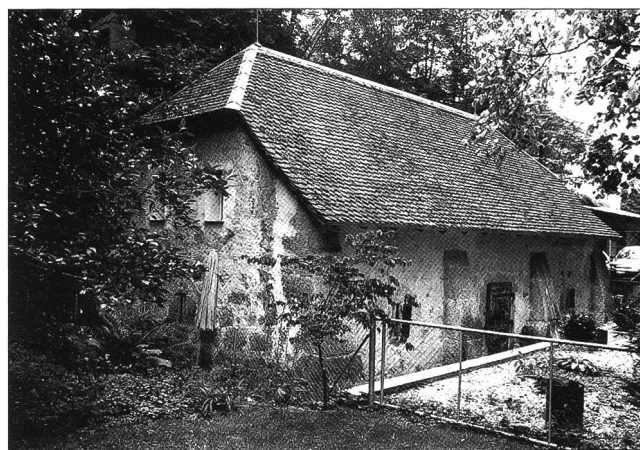
Abb. 2 Solothurn, Pulverhaus in der Steingrube, nach der Restaurierung.
