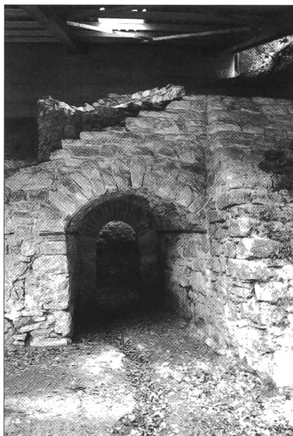
Abb. 3 Südlicher Ofen mit Bedienungsstollen (vorne) und trichterförmigem Ofenschacht (hinten), nach der Restaurierung.
