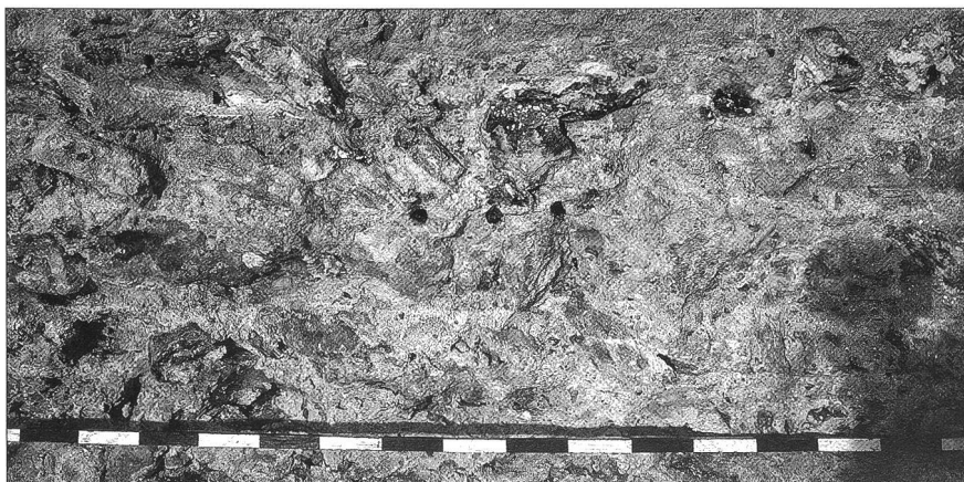
Abb. 9 Holzruten im Fundamentmauerwerk des römischen Turms. Reste eines Baugespanns?
