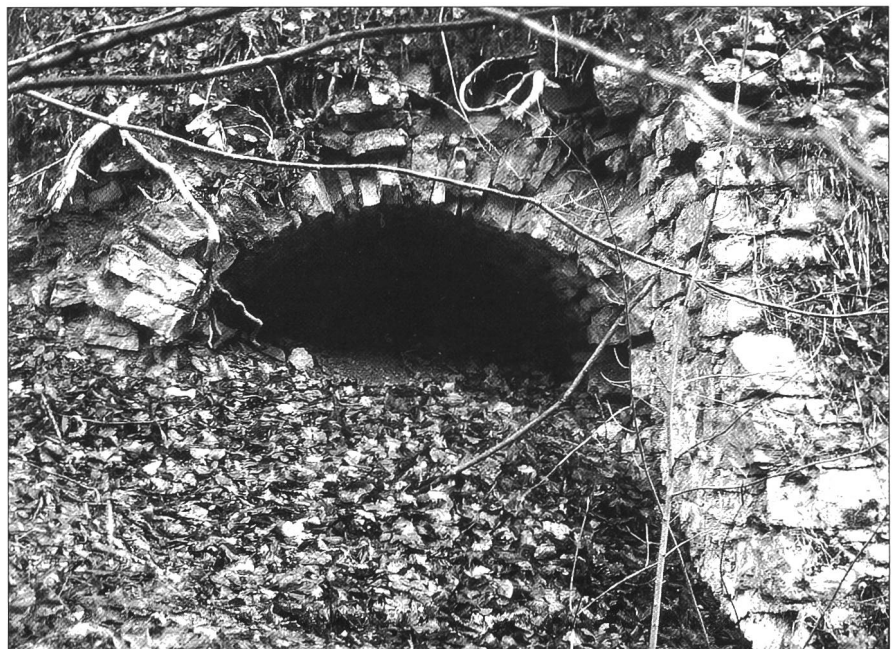
Abb. 1 Bärschwil, Kalkbrennofen «Stritteren», Zustand 1993 vor der Ausgrabung.
