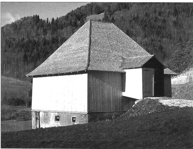
Abb. 3 Ansicht der Rückseite mit Hocheinfahrt, nach der Restaurierung.
