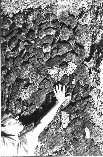
Abb. 5 Die unterste Steinlage der römischen Castrumsmauer, Untersicht (!). Im Bereich der Wandnische in der Unterfangung an der Nordwand dient sie seit 1682 als Decke.
