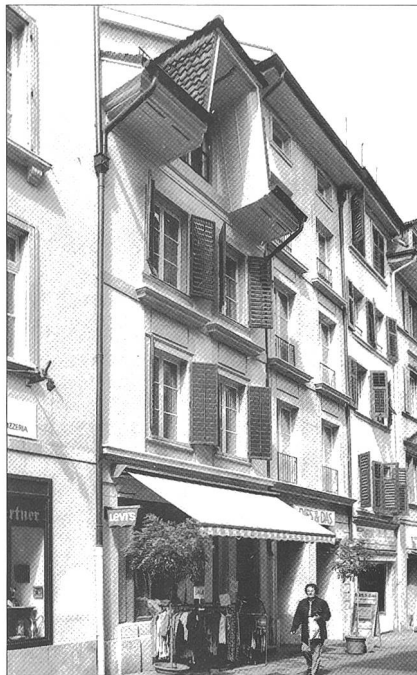
Abb. 1 Solothurn, Haus Hauptgasse 29 (in der Bildmitte). Das Haus enthält beachtliche mittelalterliche Bausubstanz, die man hinter der klassizistischen Fassade nicht vermutet.
