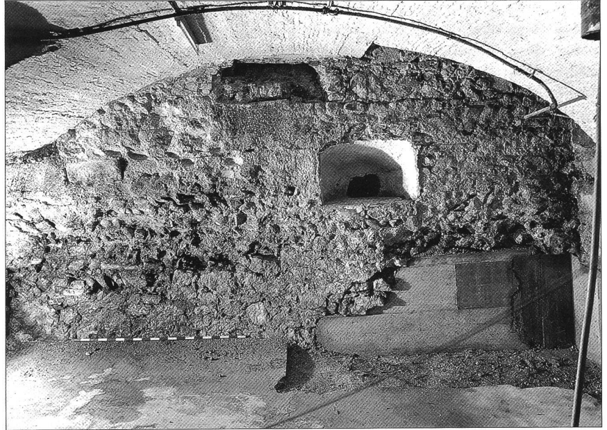
Abb. 6a Solothurn, Schriedengasse 5, 1842 erneuerter Gewölbekeller, Blick nach Süden. Bei den steinsichtigen Partien handelt es sich um Mauerwerk der römischen Castrumsmauer (rechts) und einem dazugehörigen Turm (links).
