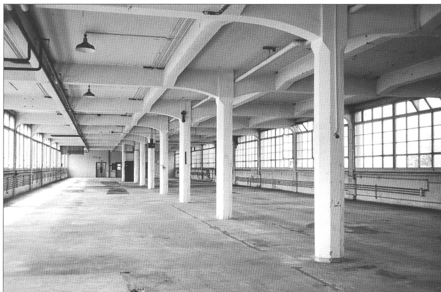
Abb. 2 Fabrikationshalle der Schuhfabrik Hug, 2002.
