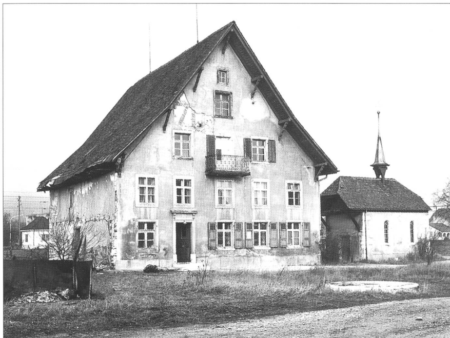
Abb. 3 Oberbuchsiten SO, Schälismühle 1985 im Zerfall...
