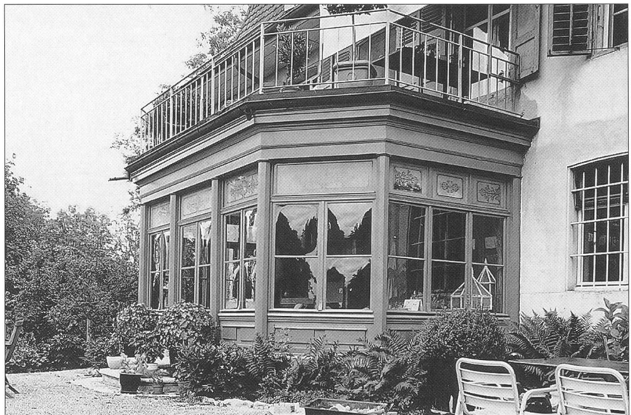
Abb. 2 ...und nach der Restaurierung 2003.
