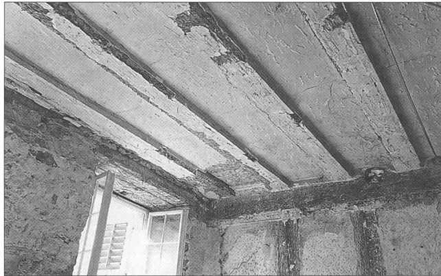
Abb. 1 Die vergipste Balkendecke nach der Demontage von zwei jüngeren darunter gehängten Gipsdecken, Fundzustand.
