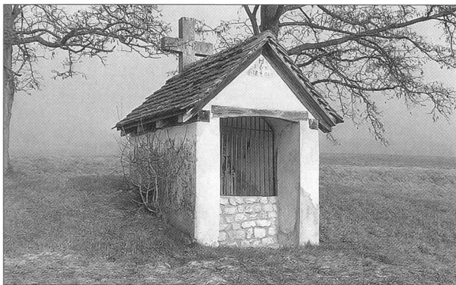
Abb. 1 Laupersdorf, Wegkapelle Käppelisacker nach der Restaurierung 2003, Ansicht von Südwesten.
