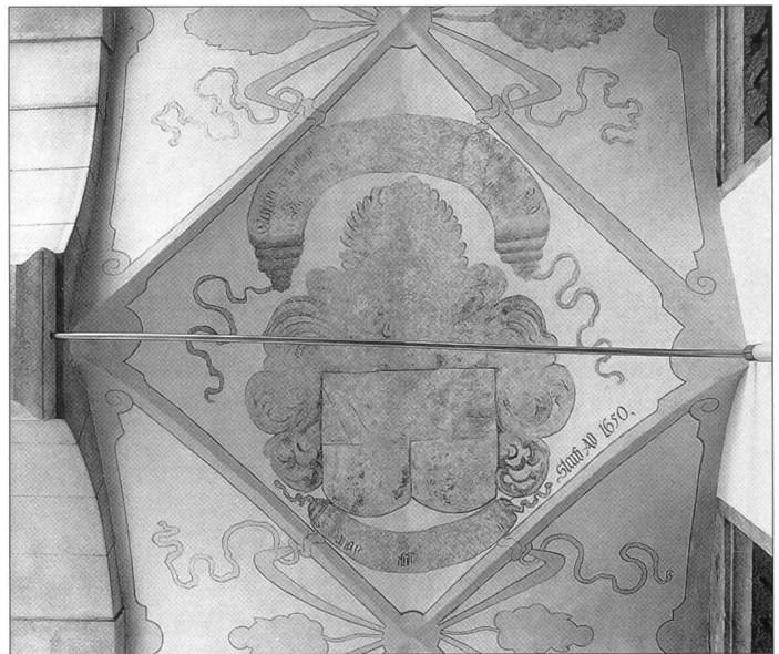
Abb. 6 ... und nach der Restaurierung von 2003.
