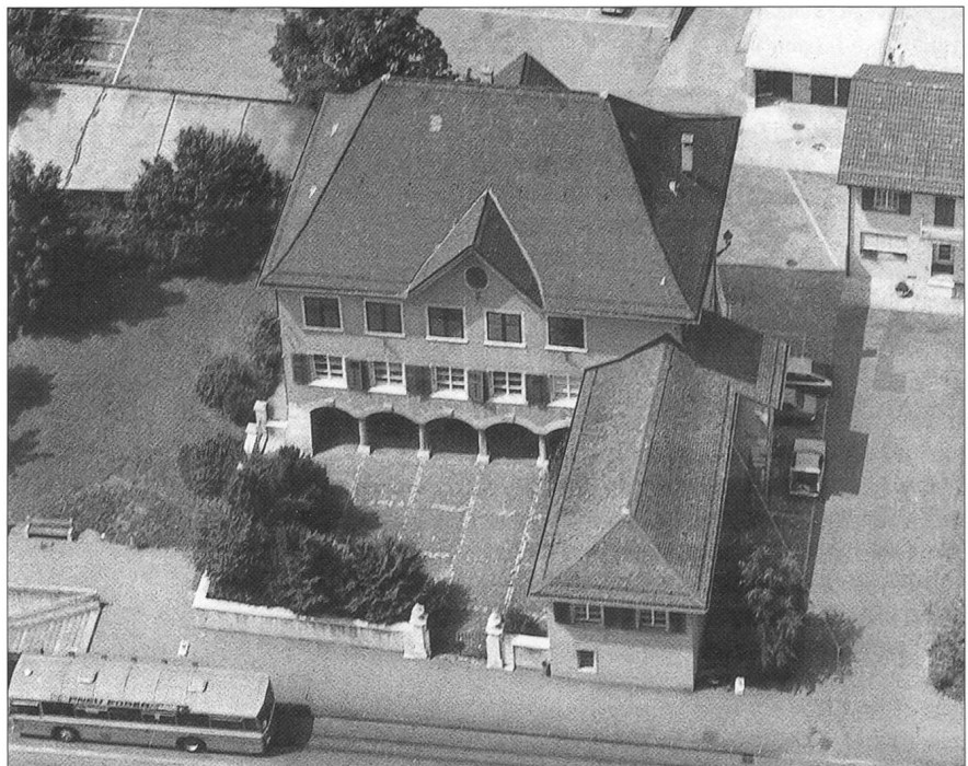
Abb. 1 Das Haus Baselstrasse 7, Flugaufnahme 1983.
