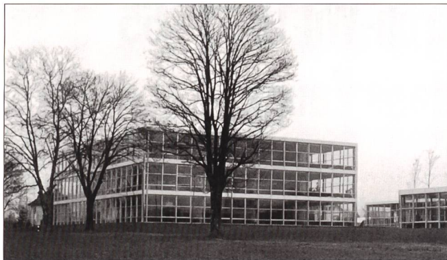
Abb. 2 Hans Zaugg, Abschlussklassenschulhaus (1962–68), Frauenfeld.
