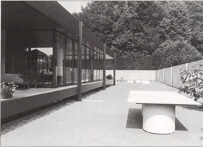
Abb. 13 Hans Zaugg, Haus Süess (1965), Starrkirch-Wil. Südwestansicht mit Terrassenhof 2005.
