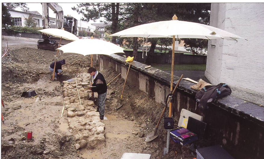
Abb. 2 Beim Strassenbau kamen in Wolfwil Mauerreste eines Vorgängerbaus der heutigen Kirche (ganz rechts) zum Vorschein.
