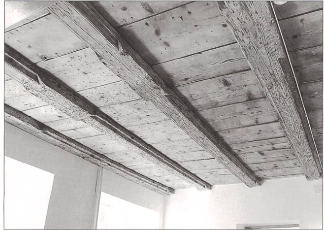
Abb. 6 Die Decke über dem Foyer mit fein profilierten Balken und eingeschobenem Blindboden aus überfällten, glatt gehobelten Brettern stammt aus der Bauzeit von 1580. Zustand nach der Freilegung und Reinigung.
