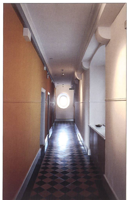
Abb. 5 Der gleiche Korridor nach dem Umbau von 2004.
