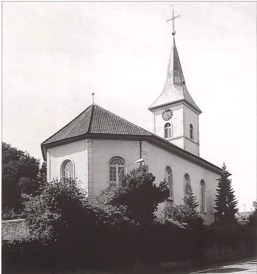
Abb. 1 Mühledorf, reformierte Pfarrkirche, Ansicht von Osten 2005.
