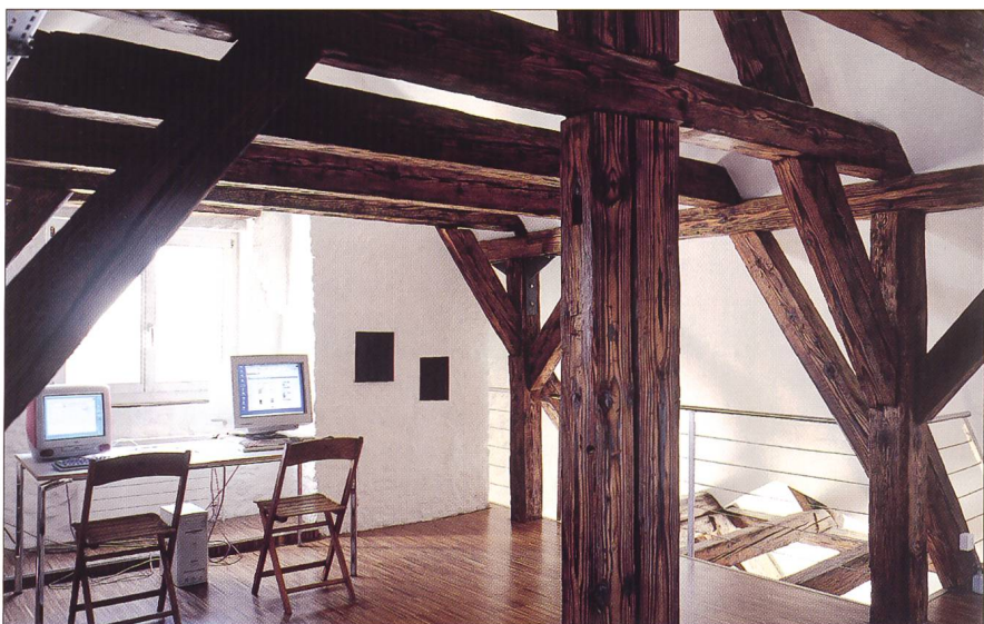
Abb. 5 Stehende Konstruktionselemente des Dachstuhls von 1635 über dem Kehlgebälk.
