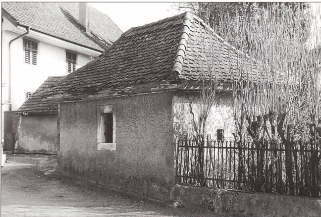
Abb. 1 Oberbuchsiten, ehemaliges «Zollhüsli» vor...
