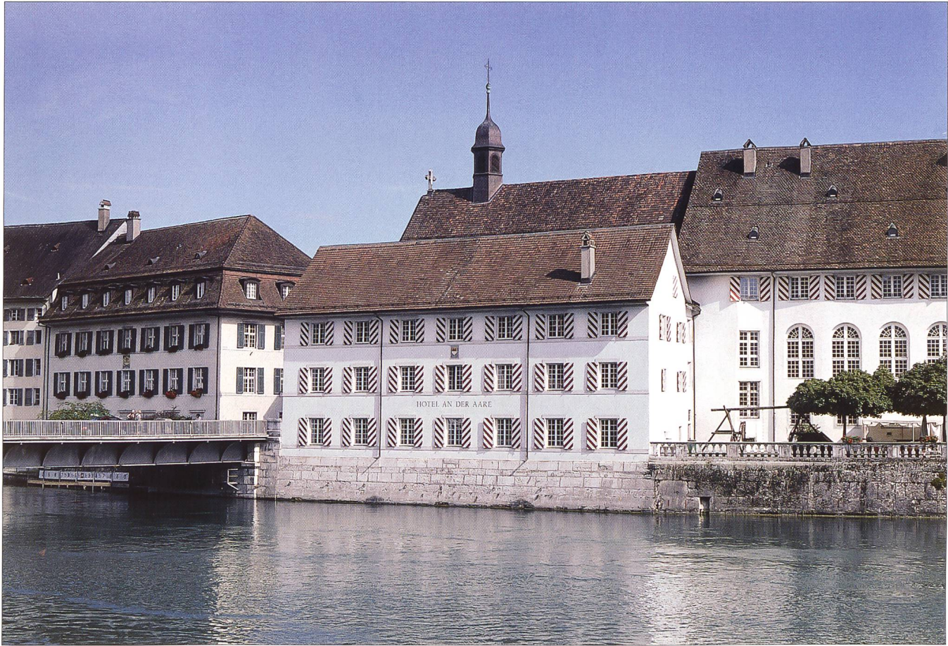
Abb. 12 Westansicht 2005, nach dem Umbau zum Hotel.
