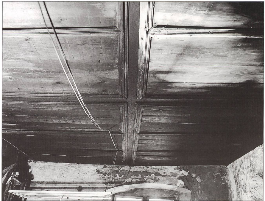
Abb. 9 Täferdecke im ehemaligen Saal im 1. Obergeschoss. Die mit feinen parallelen Ritzlinien dekorierten Tafeln sind in einem Raster von profilierten Deckleisten eingefügt. Decke aus der Bauzeit von 1594 im Zustand nach vierhundert Jahren, 1999.
