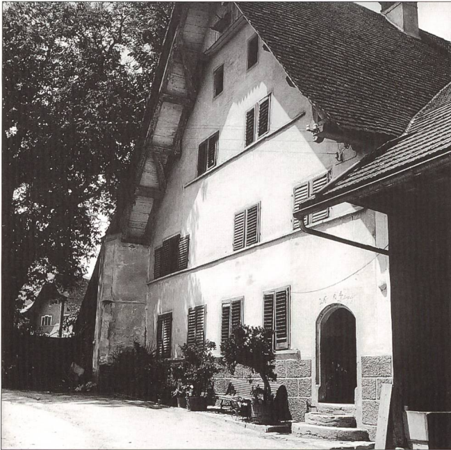
Abb. 1 Südfassade im Zustand Juni 1949.
