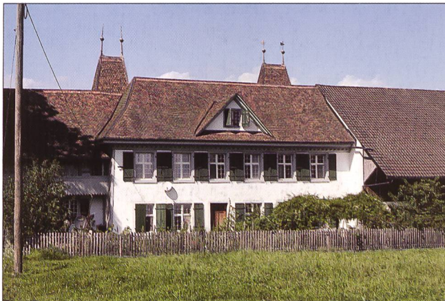
Abb. 4 Der «Buechhof» nach der Fassaden- und Dachrenovation von 2003/2004. Südansicht.
