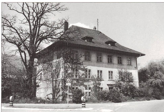
Abb. 1 Rickenbach, Herrenhaus der ehemaligen Mühle.
