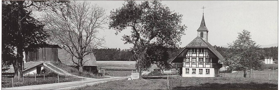
Abb. 1 Gächliwil, altes Schulhaus.
