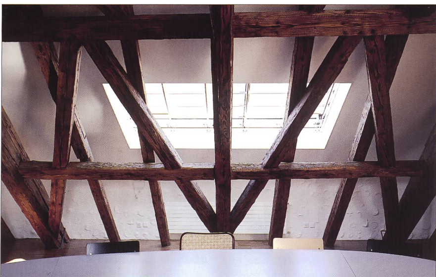
Abb. 4 Die intakt erhalten gebliebenen Windverstreben in der nördlichen Dachfläche mit dem neuen Fenster in der Dachfläche.
