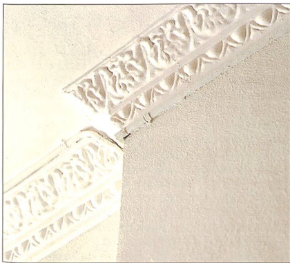
Abb. 3 Stuckdekorationen aus der Bauzeit von 1691/92.
