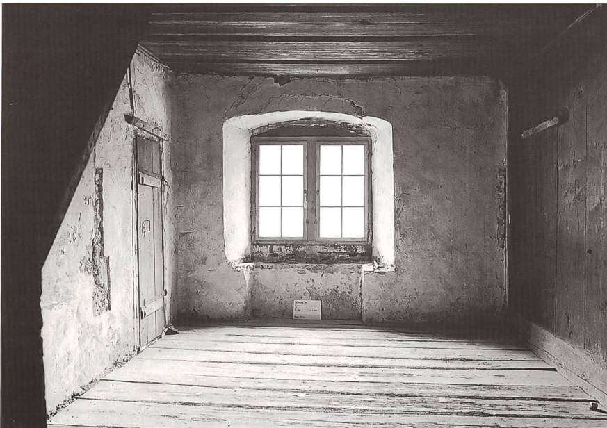
Abb. 10 Blick in eines der einfachen Zimmer im 2. Obergeschoss, Zustand 1999.
