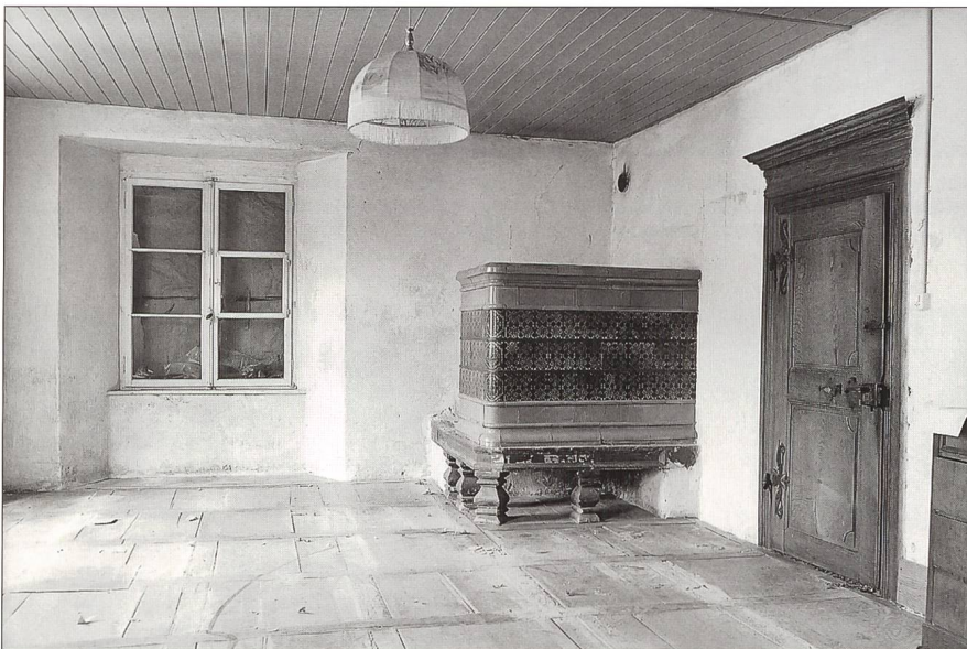
Abb. 6 Stube Nordwest im 1. Obergeschoss, vor der Restaurierung, 1999 ...
