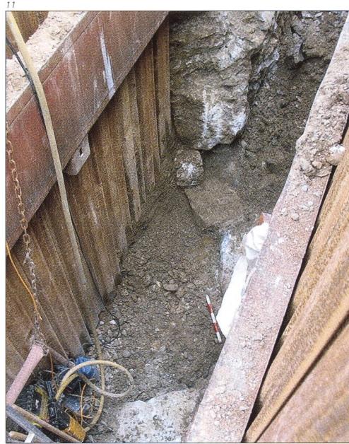
Abb. 11 Hauptbahnhofstrasse, Kanalisation 2005. Die Schanzenmauer verläuft quer durch den Leitungsgraben (im Hintergrund), rechtwinklig dazu ein Stützpfiler (im Vordergrund). Gegen Osten.
