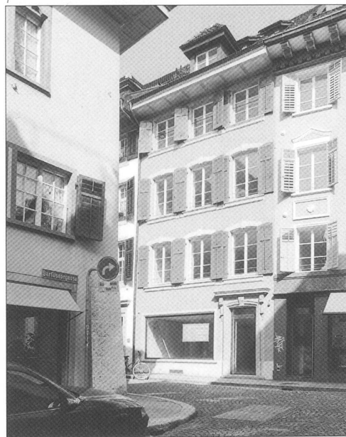
Abb. 1 Barfüssergasse 11 und 13, Zustand nach der Renovation 2006.
