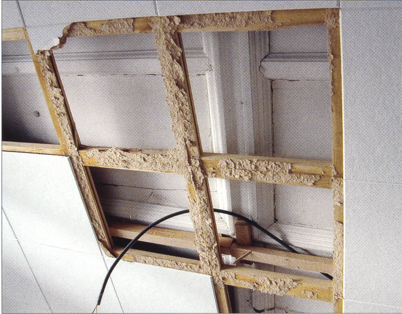
Abb. 12 Barfüßergasse 13, 3. Ober- geschoss, Täferdecke von 1641, Fundzustand, Profil Mittelfries und Deckleiste.
