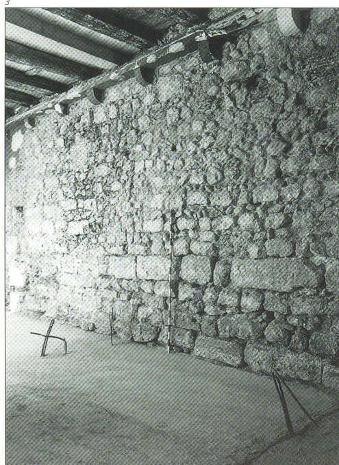
Abb. 3 Schrägsicht des nahezu unbefensterten Abschnitts der ersten Erweiterung. Wo das Mauerwerk nicht durch jüngere Eingriffe gestört ist, zeichnen sich deutliche horizontale Schichten ab.
