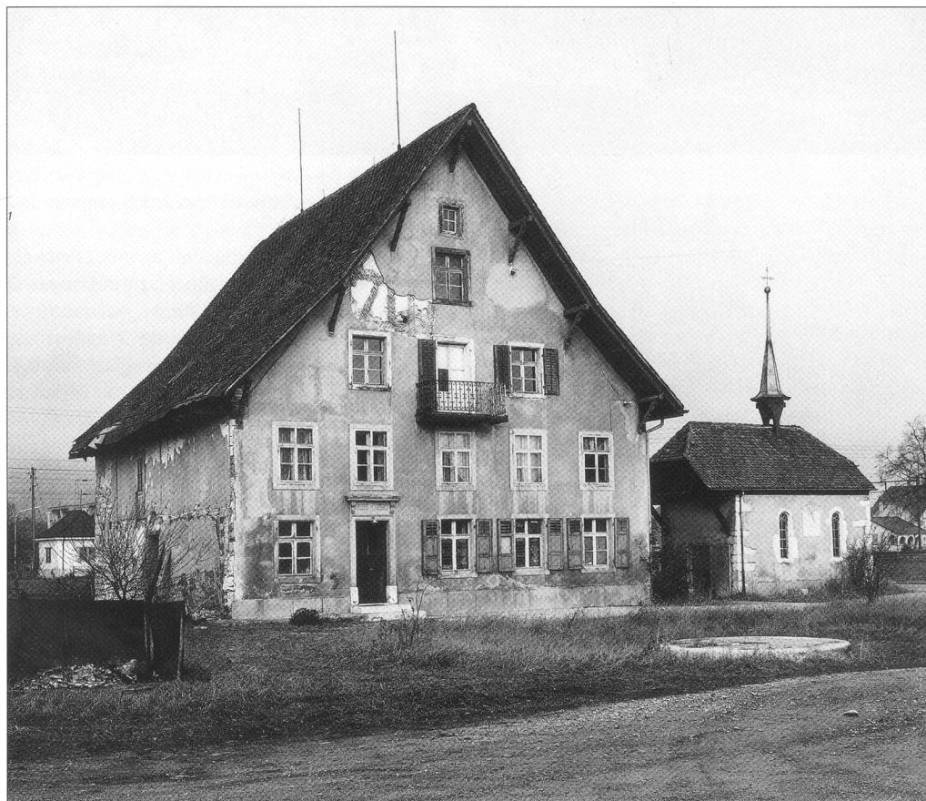
Abb. 1 Oberbuchsiten, «Schälismühle», Zustand vor der Restaurierung 2002/2003.
