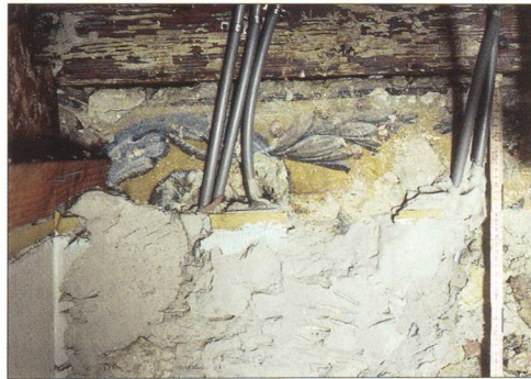
Abb. 16 1. Obergeschoss, Korridor im ehemaligen Saal, Stuckprofil von ca. 1750.
