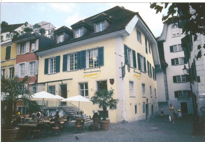
Abb. 1 Das Haus Friedhofplatz 14 nach der Renovation von 2006, Zustand 2007.
