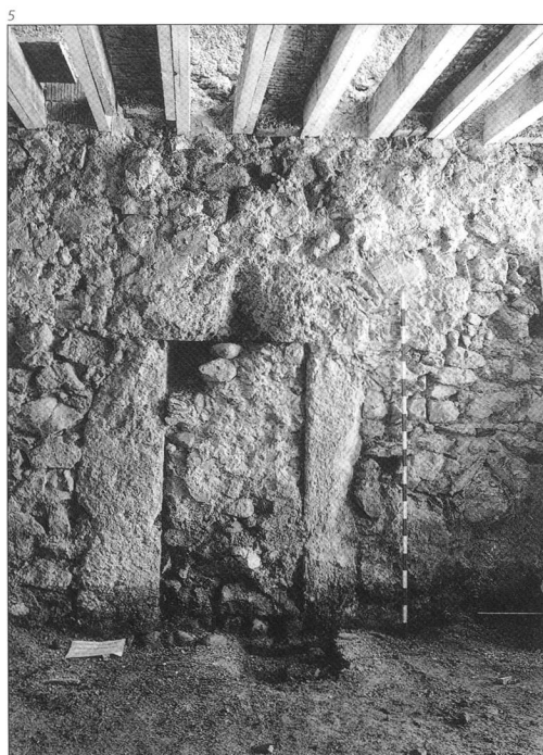
Abb. 5 Brandmauer Süd, Mauerwerk der zweiten Bauphase im Bereich Erdgeschoss, mit zugemauertem Türöffnung und sekundär eingesetzter Lichtnische daneben.
