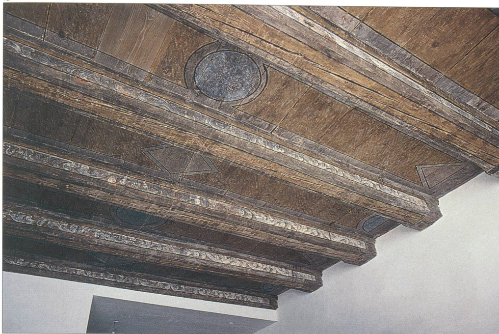
Abb. 12 2. Obergeschoss, Stubendecke nach der Restaurierung von 2006.
