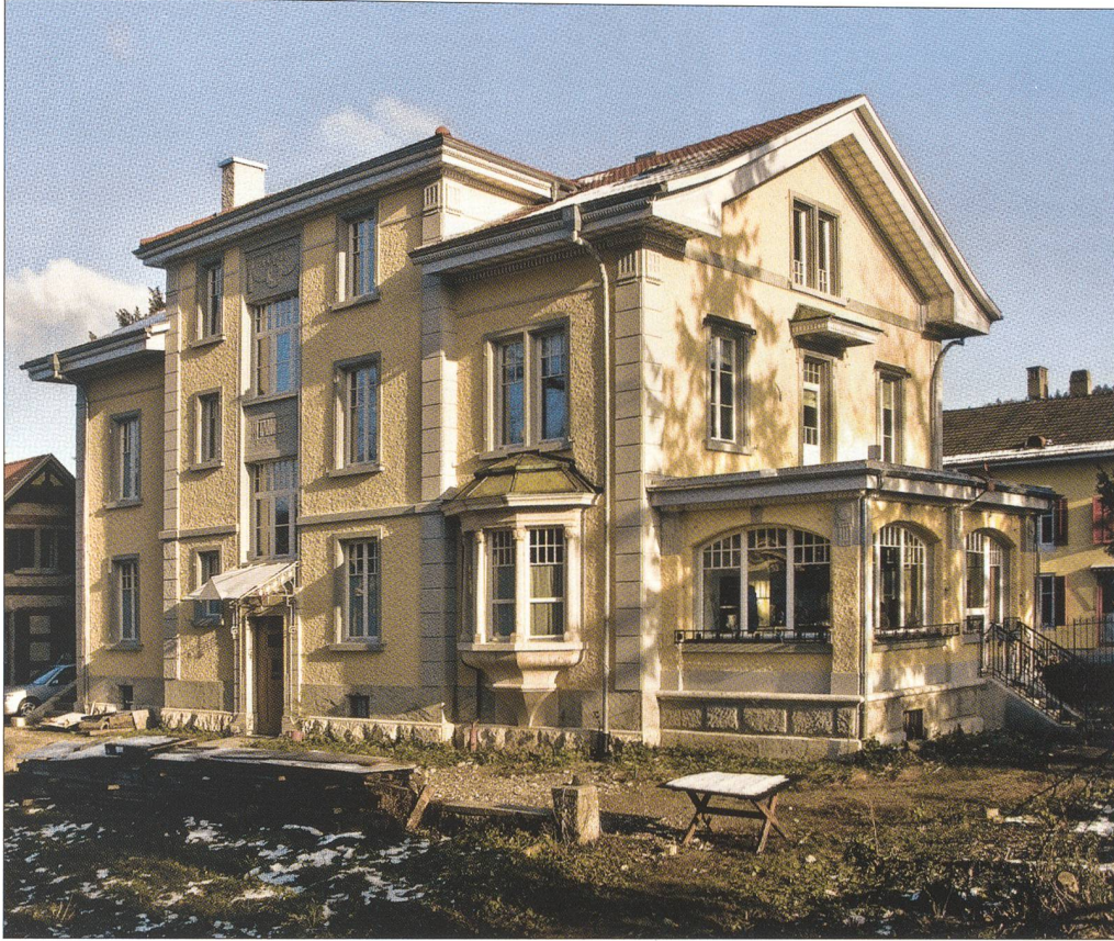
Abb. 12 Blick vom Garten zur restaurierten Villa.
