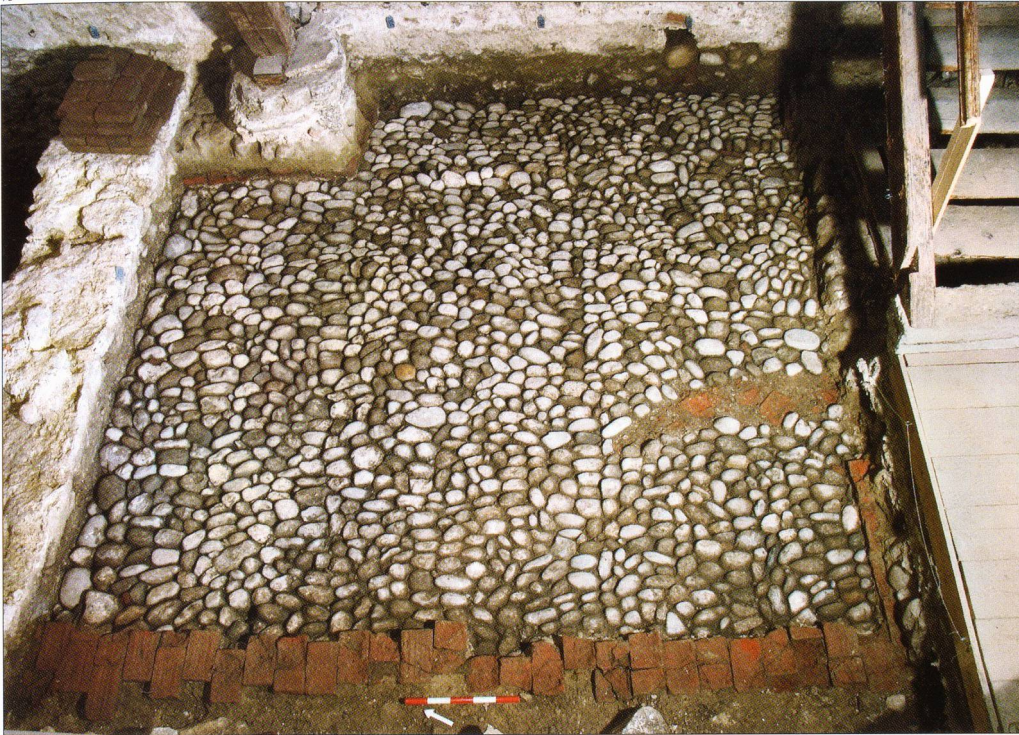
Abb. 16 Der zweite Boden des frühneuzeitlichen Speichers aus Bollensteinen, links die Nordmauer des Speichers. Blick gegen Nordosten.
