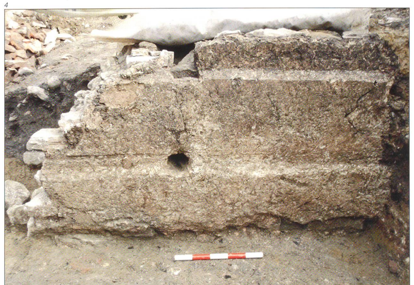
Abb. 4 Ansicht der verputzten Ostmauer M1 der Kryptoportikus. In der Bildmitte ist der Durchlass für eine Wasserleitung sichtbar, links und rechts des Loches die Haftrillen der seitlich wegführenden Leitungsrohre.
