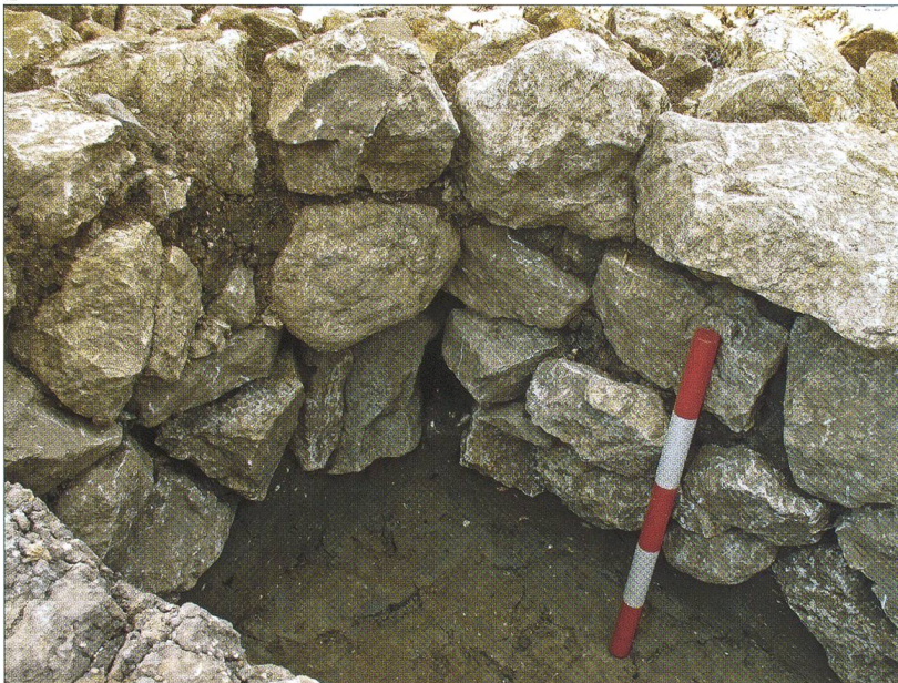
Abb. 11 In der Ecke von M2 und M3 (links) waren rostrote Jurakalksteine verbaut. Die Anschlussmauer M7 (rechts) enthält praktisch keine verfärbten Steine.
