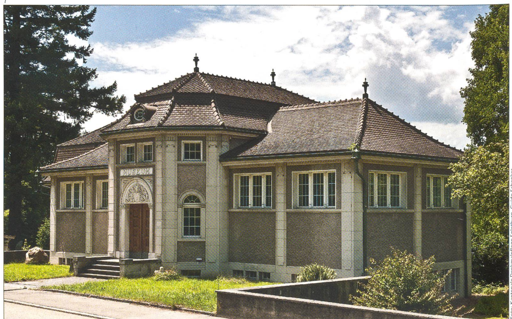
Abb. 1 Schönenwerd, Oltnerstrasse 80, Schweizerisches Zündholzmuseum. Die Aufnahme zeigt den Bau von 1909 von Nordosten. Foto vor der Restaurierung 2010.
