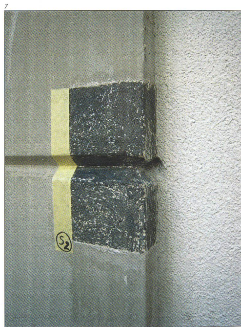
Foto: Kantonale Denkmalpflege Solothurn, Stefan Blank.
