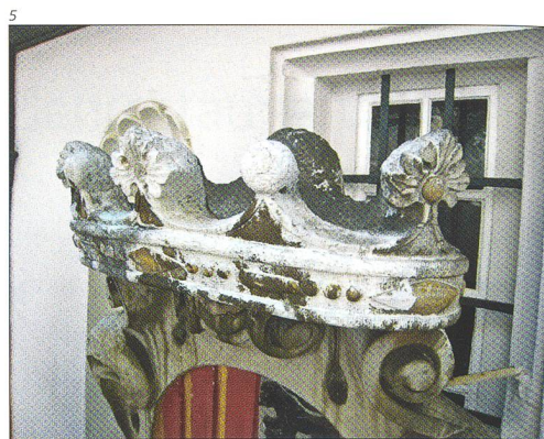
Foto: Kantonale Denkmalpflege Solothurn, Stefan Blank.
