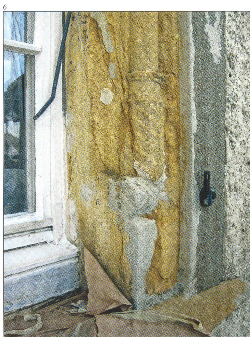
Foto: Kantonale Denkmalpflege Solothurn, Stefan Blank.
