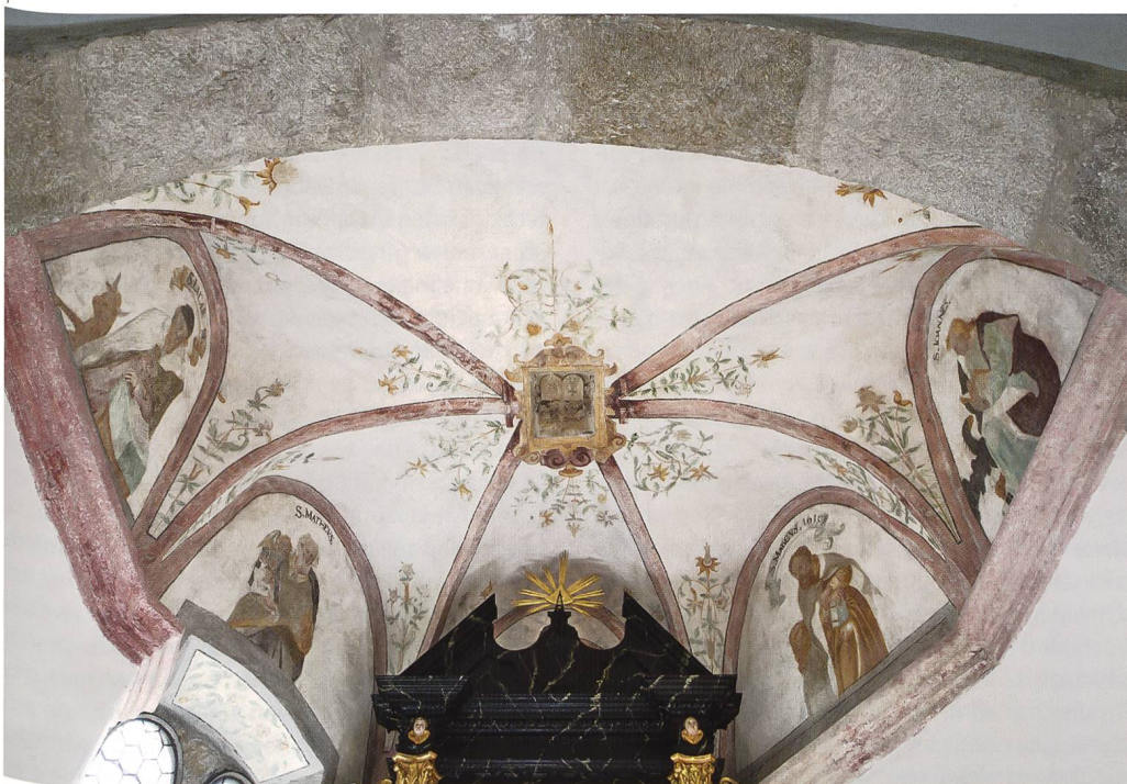
Abb. 1 Oberdorf, Kapelle St. Michael. Blick in das Gewölbe des Chores. Foto 2013.
