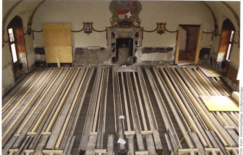
Abb. 19, 20 Kantonsratssaal, während der Demontage- und Umbauarbeiten, Sommer/Herbst 2012. 19) Blick nach Osten, Zustand nach der Demontage der Möblierung. 20) Blick nach Westen, nach dem Entfernen der Bodenbretter. Alte Balkenlage, bei der Einrichtung des ersten grossen Saals 1574 demontiert und in veränderter Lage wieder neu eingebaut. Die Balken sind zur Verbesserung der Statik seitlich bereits neu verstärkt.
