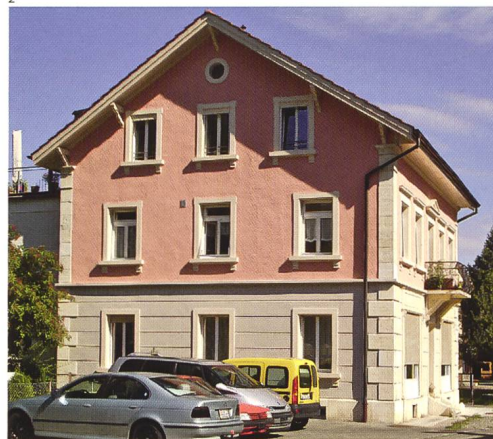
Foto: Kant. Denkmalpflege, Markus Schmid.
