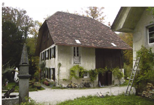
Foto: Kant. Denkmalpflege, Guido Schenker
