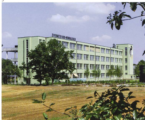
Foto: Kant. Denkmalpflege, Guido Schenker
