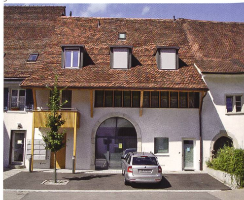
Foto: Kant. Denkmalpflege, Markus Schmid.
