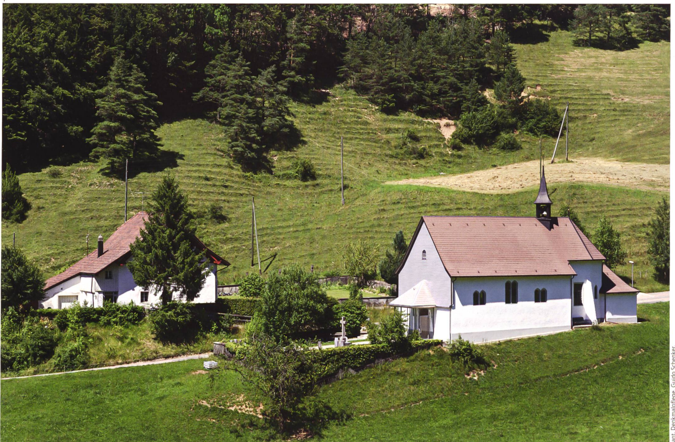
Abb. 1 Gänsbrunnen. Blick von Süden auf die Gebäudegruppe mit Pfarrkirche St. Joseph und Pfarrhaus. Zustand nach der Restaurierung der Kirche, mit neuem Windfang.
