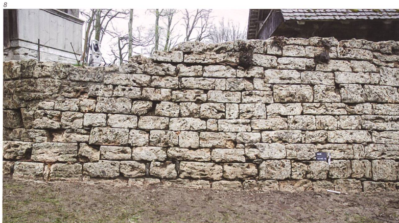
Abb. 8 Mauer M26 aus Tuffsteinquadern nach der Entfernung des Pflanzenbewuchses und der Moospolster. Aufnahme 2012; von Norden.
