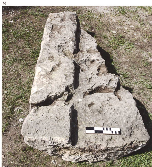
Abb. 14 Türgewändestein aus Tuff. Er diente während Jahrzehnten als unterster Tritt der Treppe zum Turmeingang. Aufnahme 2012.
