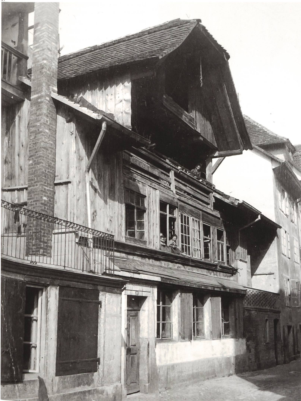
Archiv Kant. Denkmalpflege Solothurn.
