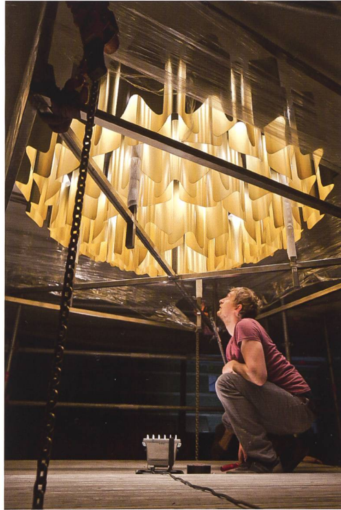
Abb. 28 Aufzug und Montage des exklusiv für den Theatersaal hergestellten grossen Deckenleuchters.
