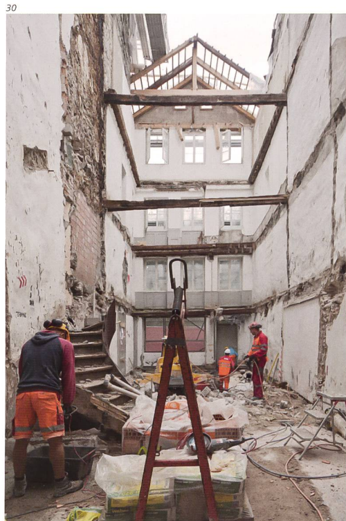
Abb. 30 Administrationsgebäude, Theatergasse 16. Aufgrund des schlechten Zustandes der alten Balkenlagen und der geplanten grossen Eingriffe für Lift, Treppen und sonstige Installationen musste das Gebäude auskerniert werden.
