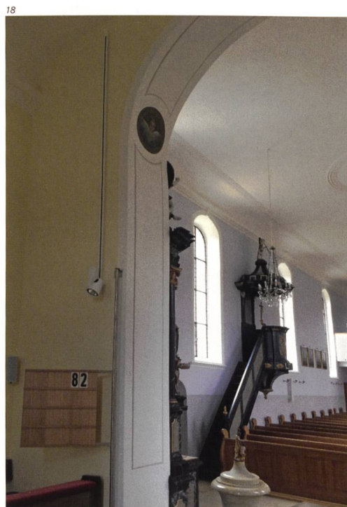
Abb. 18 Wandfassung nach der Restaurierung 2015 vom Chor aus Richtung Südwall des Schiffs: Gelbocker des Altarraums, Rahmung der historistischen Wandmalereien sowie Grauton der Sockelzone (ehemals Täfer) und Blaugrau der Wände im Schiff (ehemals Tapetenmalerei).
