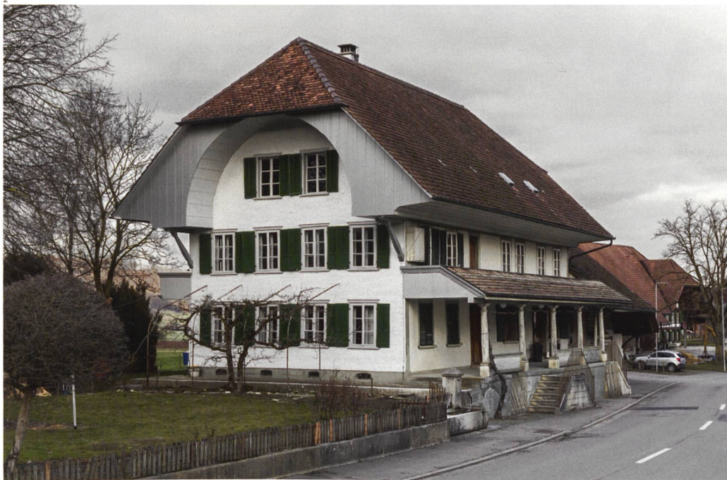
Abb. 2 Ansicht von Südwesten, nach der Restaurierung 2013–2015.
