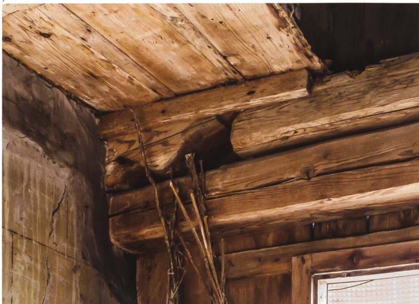
Abb. 7 An der Verbindung zwischen der Dachkonstruktion der Laube und der Fassade sind auch mehrere Bauetappen ablesbar.
